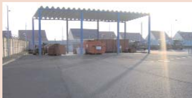
Aire de stockage des déchets
