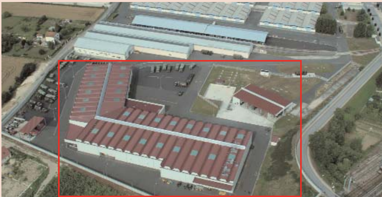
Photo aérienne du NTI 3
