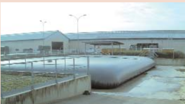
Essais de réservoirs souples
